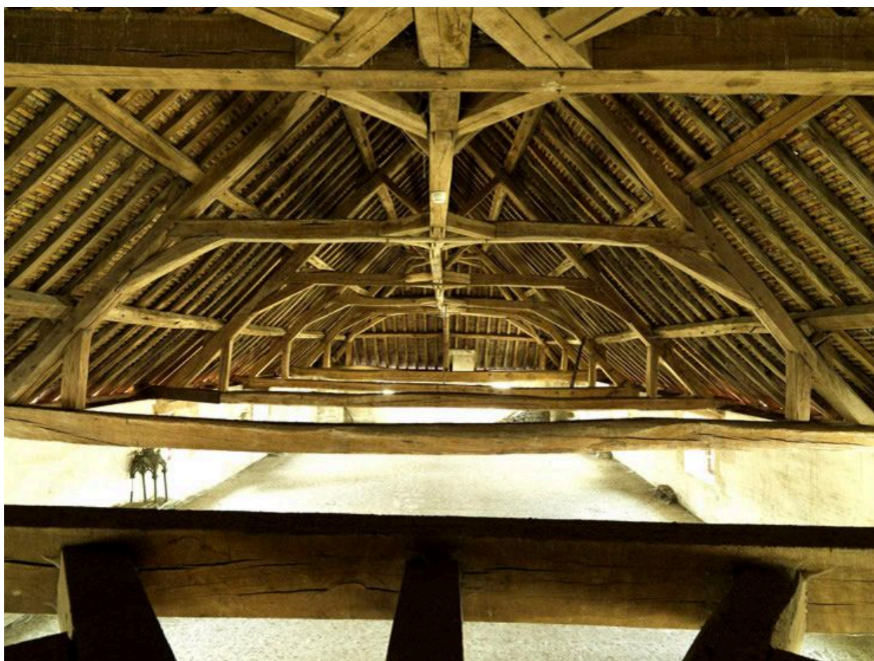
Vue d'ensemble de la charpente, depuis le sud.
