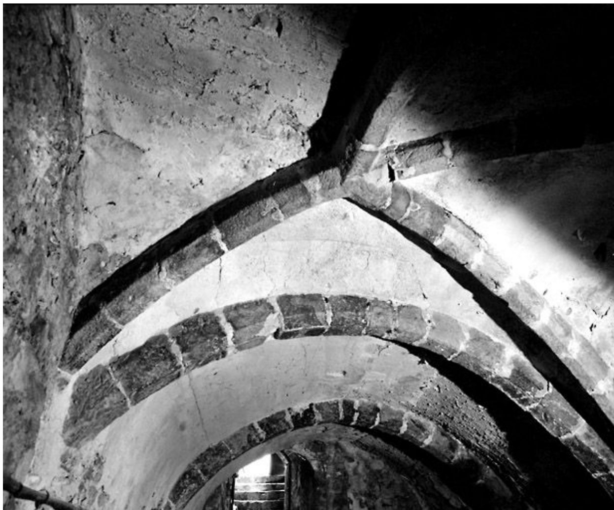
La cave : vue depuis l'ouest, avec la voûte d'ogives.
