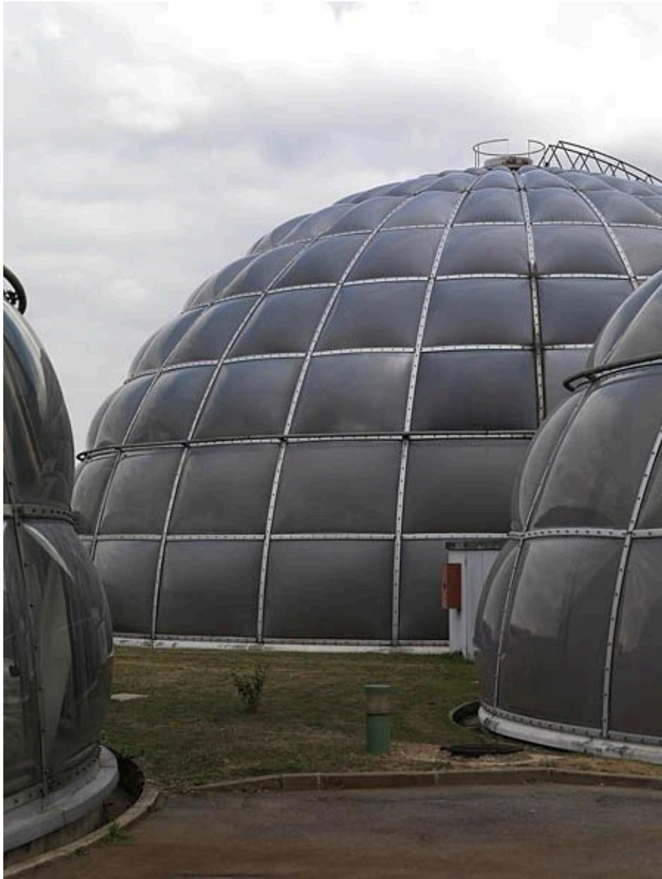
Gros plan sur les coupoles constituées de feuilles de polyméthacrylate de méthyle (plexiglas) coulées et posées sur des ossatures métalliques tubulaires.
