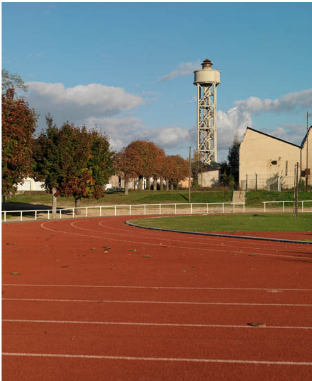
Le stade Paul Hebras. Au fond, le chateau d'eau en ciment armé (1902).
