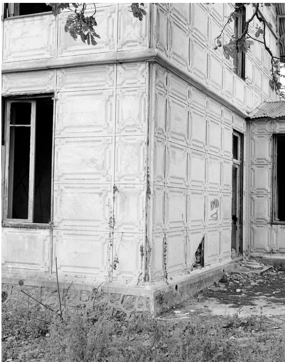
Détail du traitement d'angle (état en 1991).
