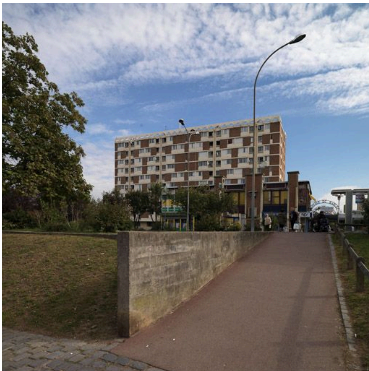
L'immeuble de 9 étages vu de l'allée de la Poste.
