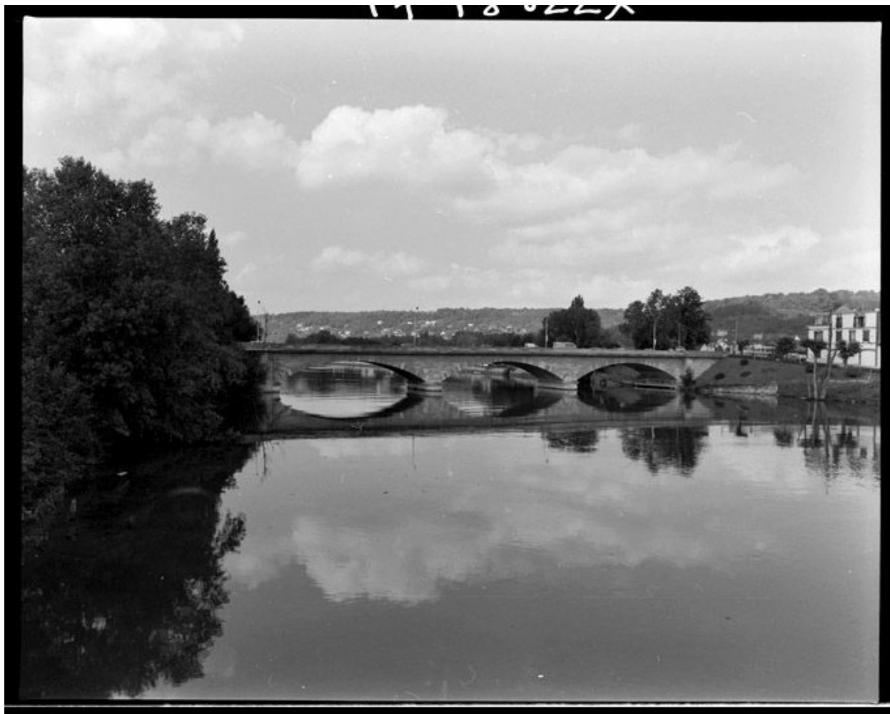
Pont routier sur la Seine dit Pont neuf ou Pont Perronet. Vue d'ensemble.
