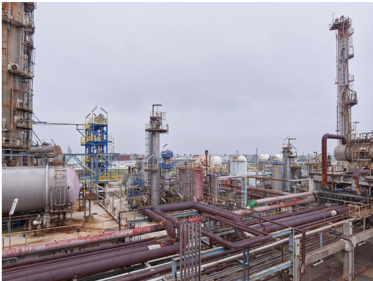
Unités Est - Zone FCC (Unité 651). Vue générale.
