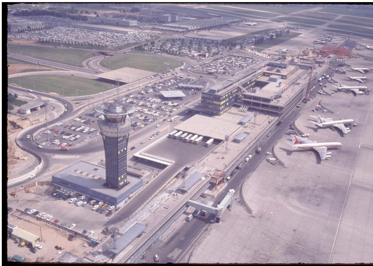
1968 1971, la construction d'Orly-Ouest et des satellites d'Orly-Sud vue prise en 1969 depuis le sud ouest.
