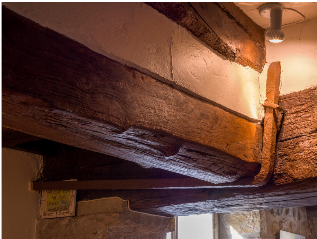
Détail des poutres de la pièce située au rez-de-chaussée du corps de bâtiment ouest.
