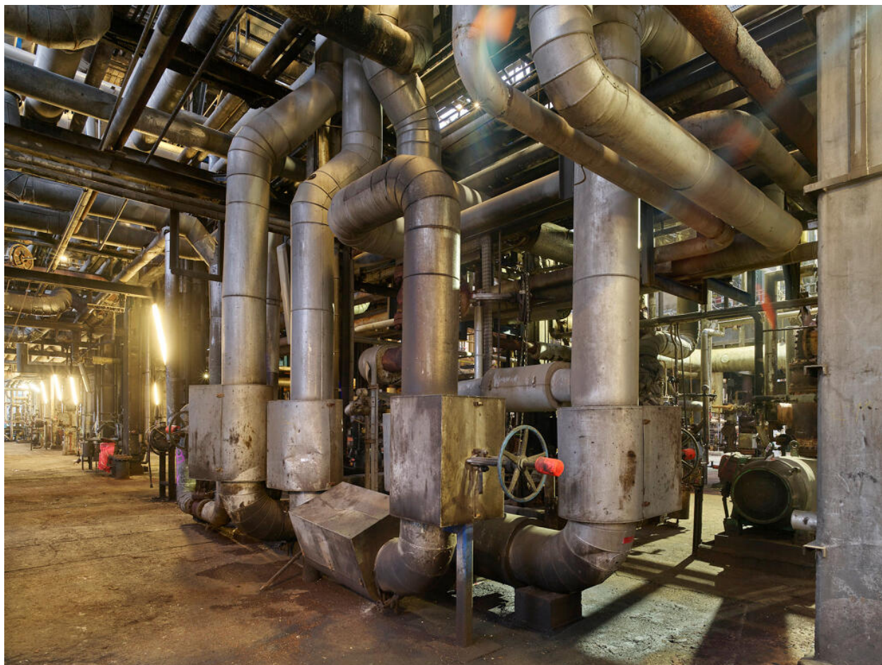
Unités Ouest - Zone de distillation (Unité 612). Tuyauterie de sortie et de bypass de la pompe Booster (permettant l'optimisation du débit de l'Unité), mise en place dans les années 2000.
