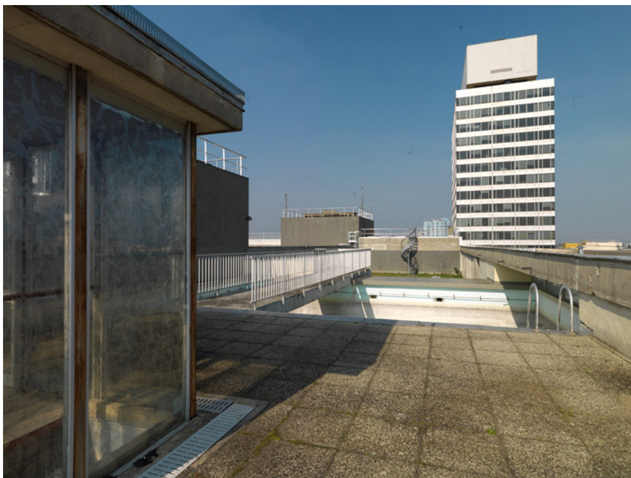
Le toit de la préfecture avec sa piscine.
