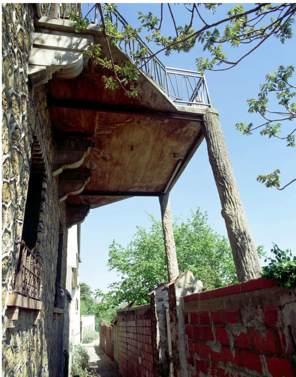
Vue du balcon soutenu par deux poteaux en ciment imitant le bois écoté qui enjambent la sente des Billeries, à l'arrière de la maison.
