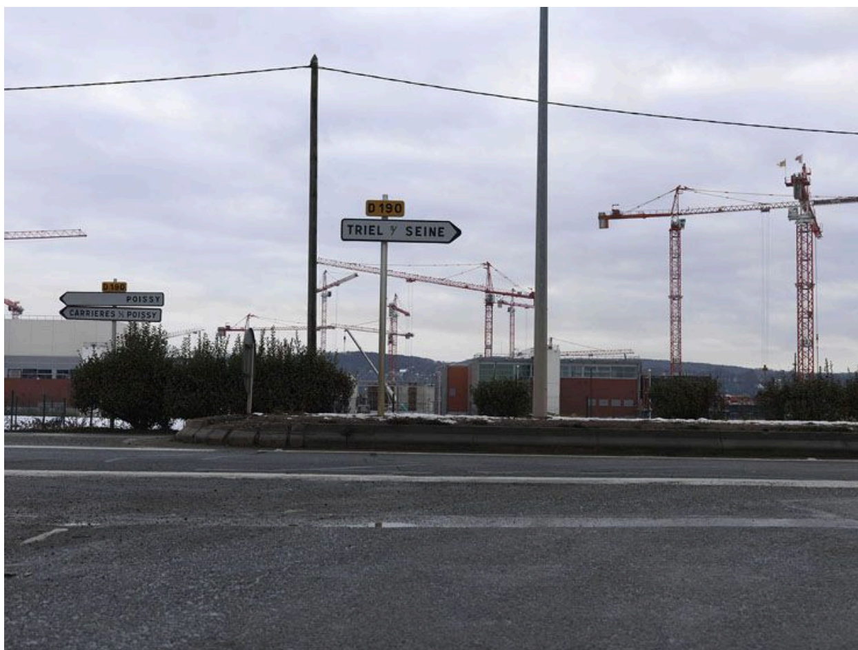
Triel-sur-Seine : chantier le long de la D 190.
