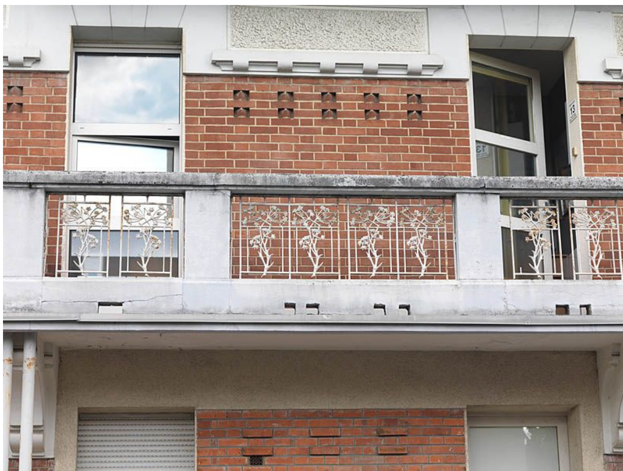
Orly, immeuble, 38 allée des Charmilles. Détail du balcon.
