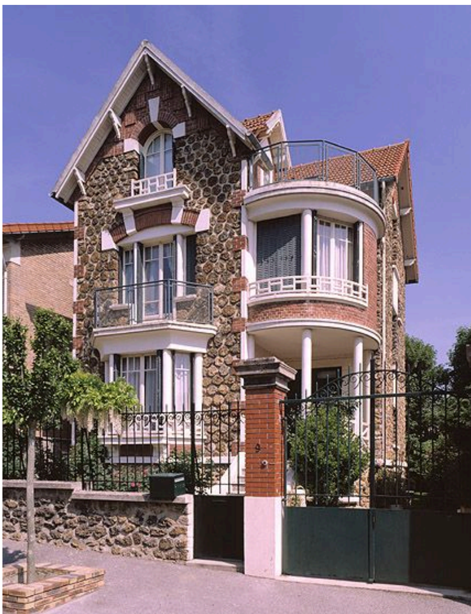
Maison, 9 rue Louis Léon Lepoutre. Vue d'ensemble.
