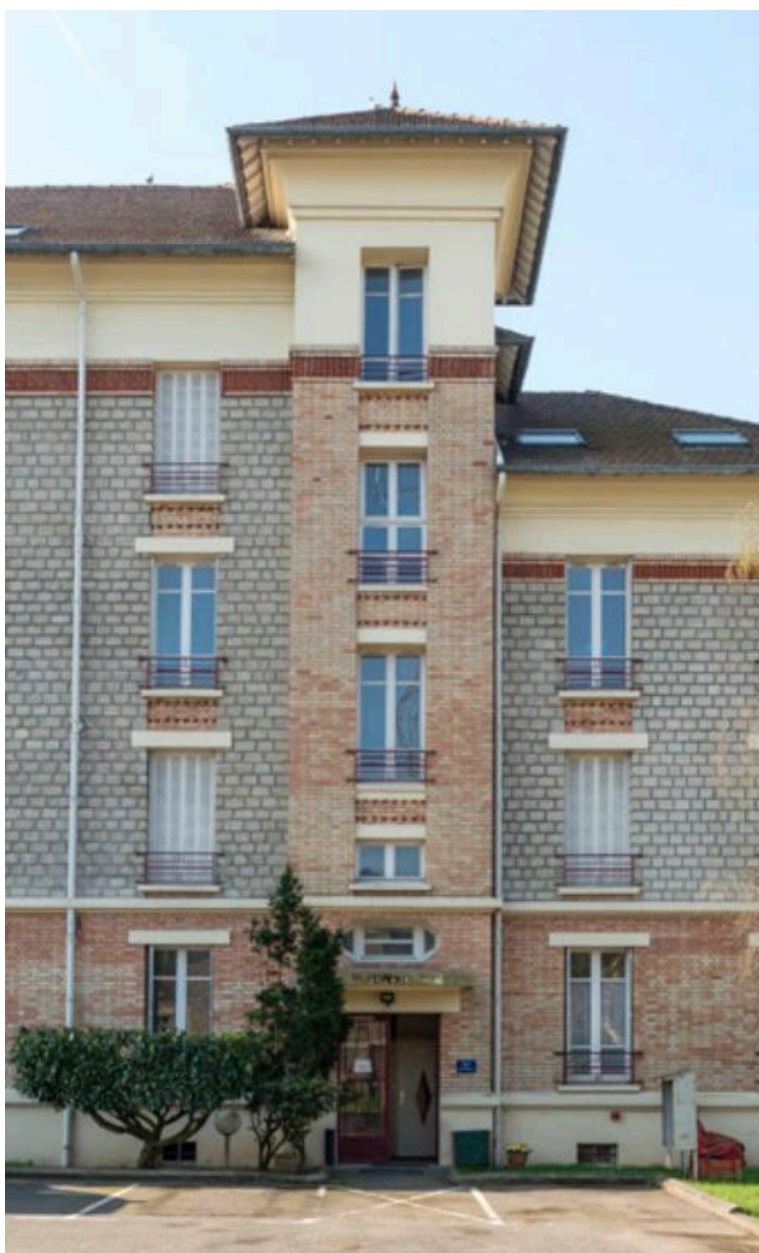
Travée d'escalier en façade.
