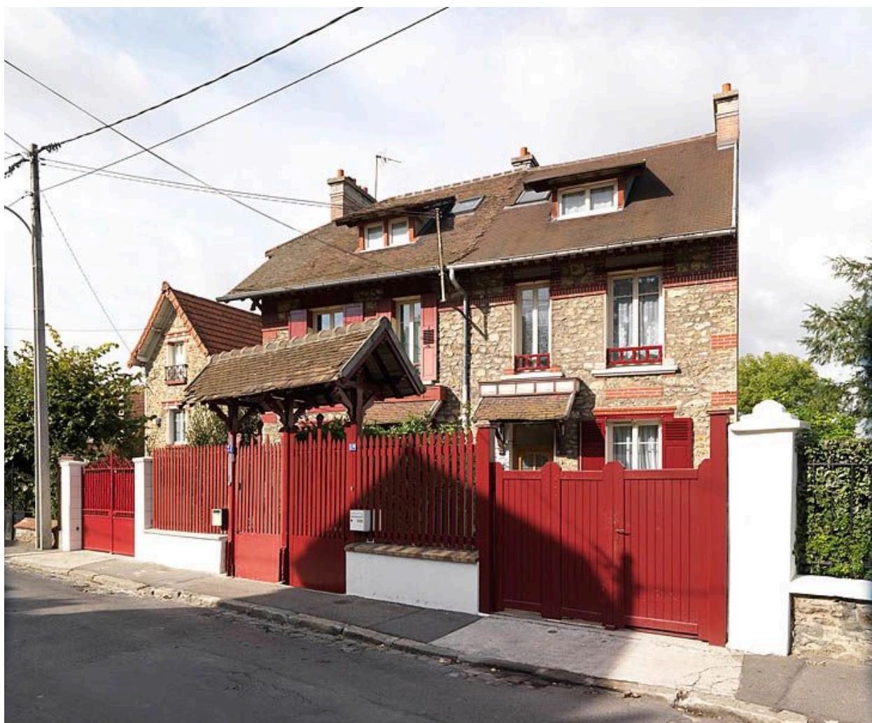
Villeneuve-Saint-Georges, maison jumelée, 31, 31 bis rue de Bellevue. Vue d'ensemble.
