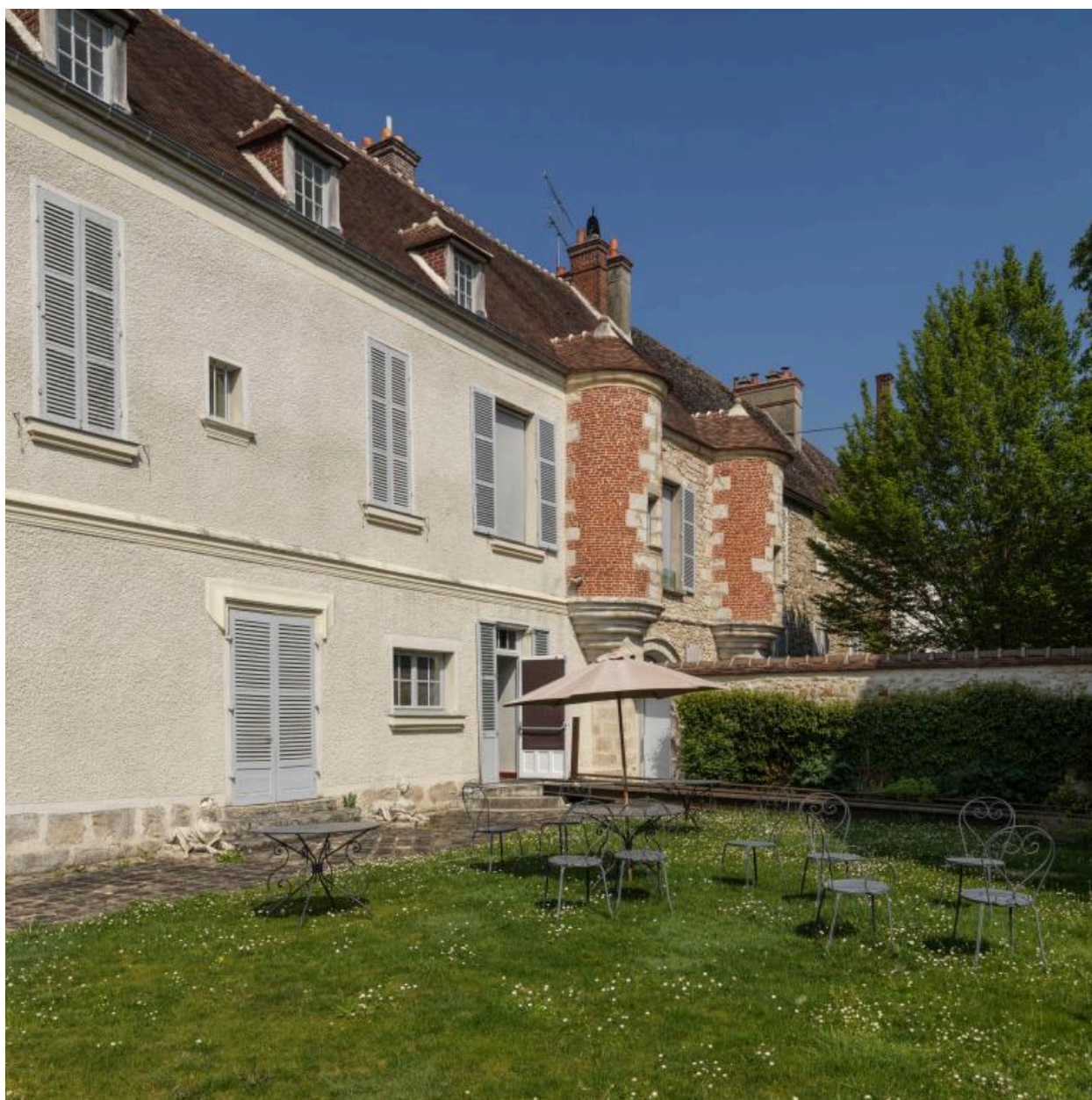
Vue de la façade du bâtiment principal
