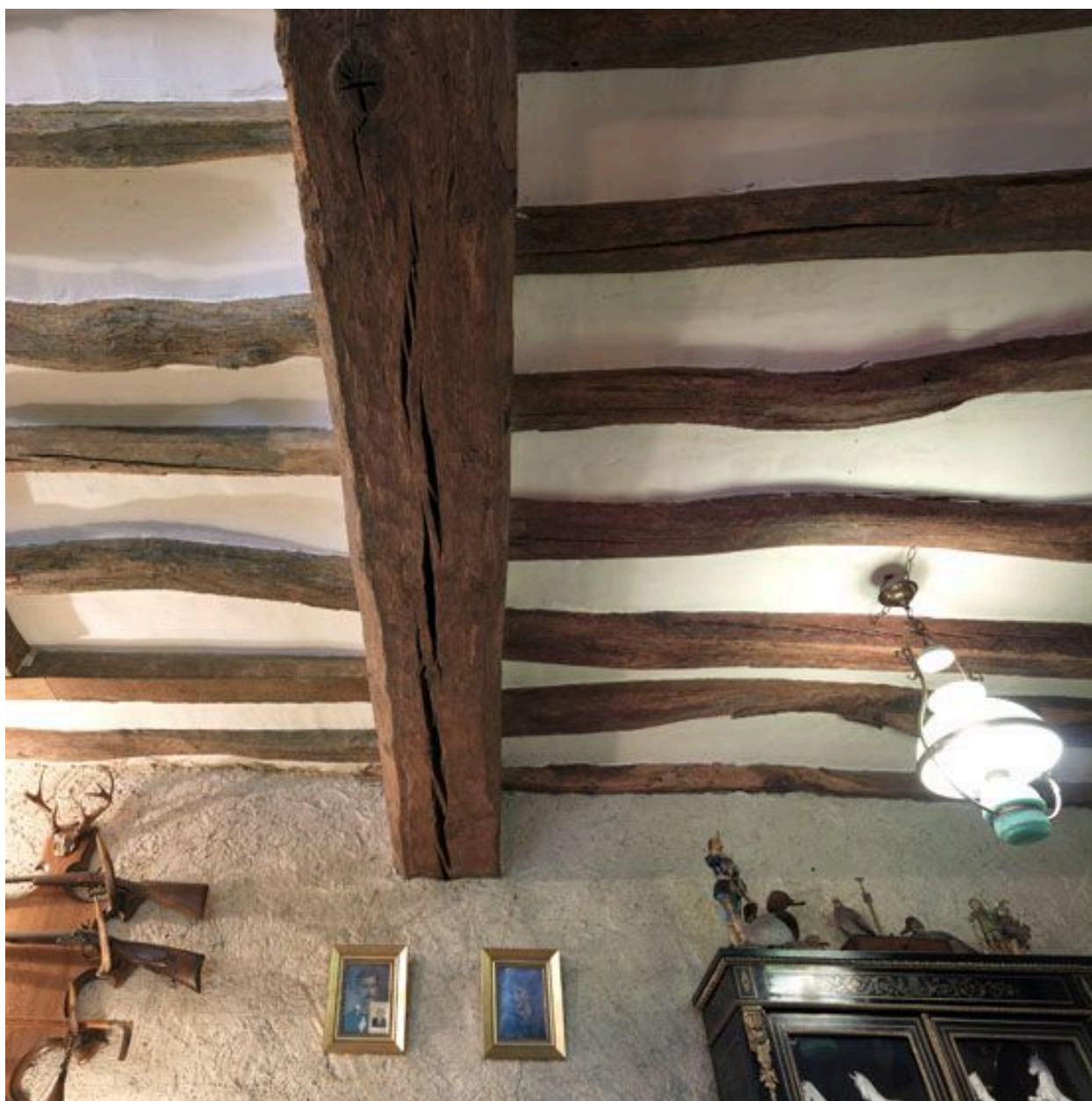
Plafond de l'ancien cellier transformé en séjour.
