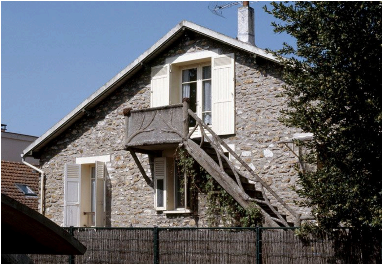
Pavillon, 1 rue des Mariniers : façade du pavillon avec escalier extérieur et balcon en ciment moulé imitant le bois.
