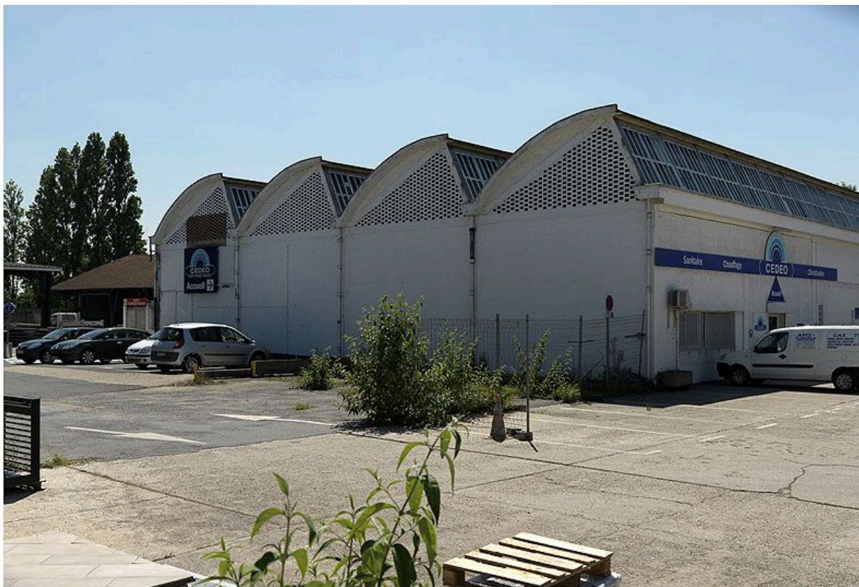
Choisy-le-Roi, entrepôt industriel de l'ancienne faïencerie Boulenger XX, 138 avenue de Villeneuve-Saint-Georges. Vue d'un des bâtiments à quatre nefs couvertes de sheds en voile béton.
