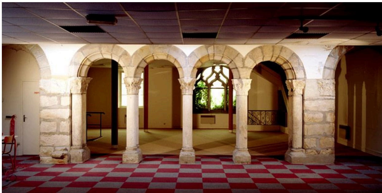
Arcade du cloître : vue d'ensemble, depuis l'est.
