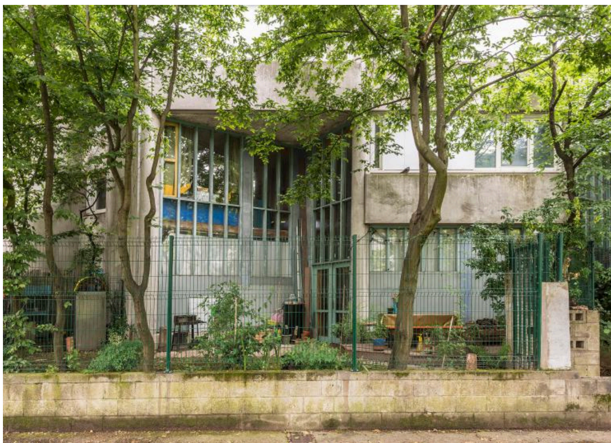
Vue de la verrière d'ateliers d'artistes au rez-de-chaussée, allée Nicolas de Staël (3)
