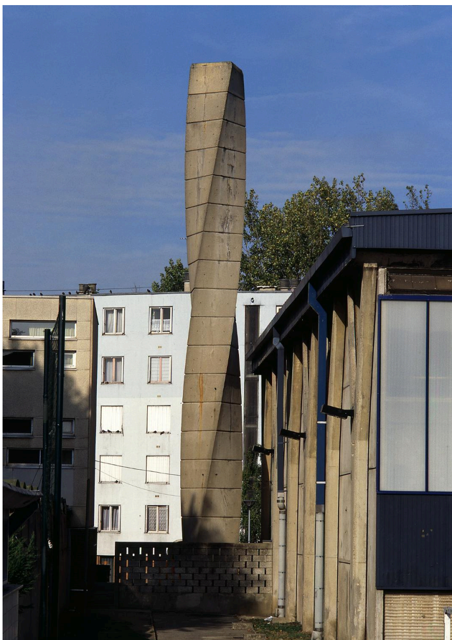
Elévation extérieure sud et cheminée
