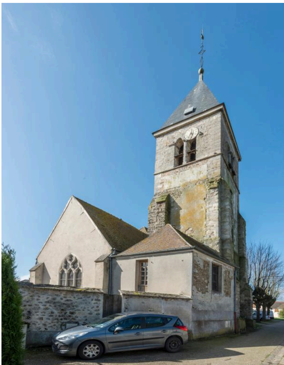
Vue extérieure, depuis le nord-est : le clocher, le chevet et la sacristie (promise à disparition).
