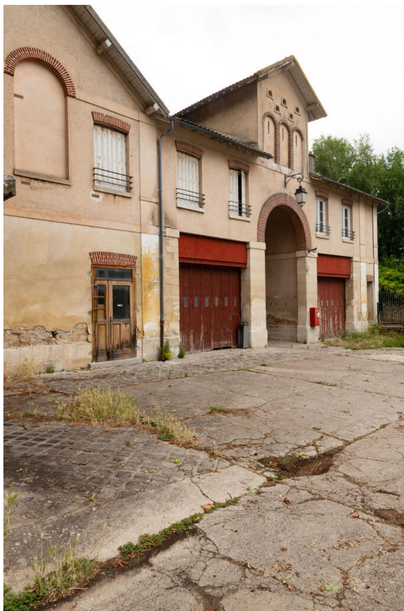
Détail de la façade sud.
