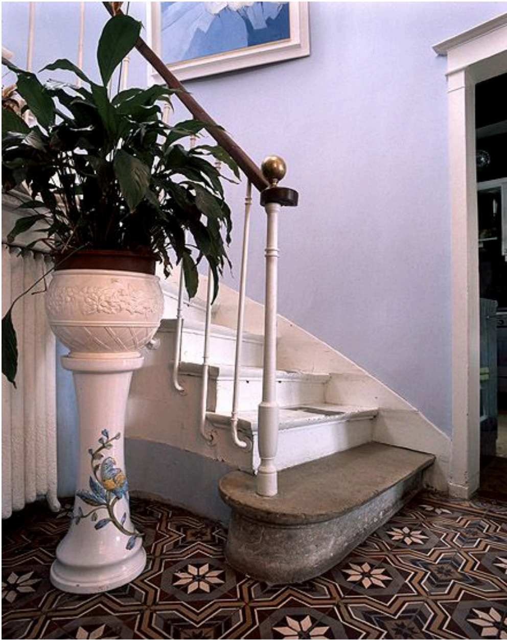
Le départ de l'escalier à marches formant limon.
