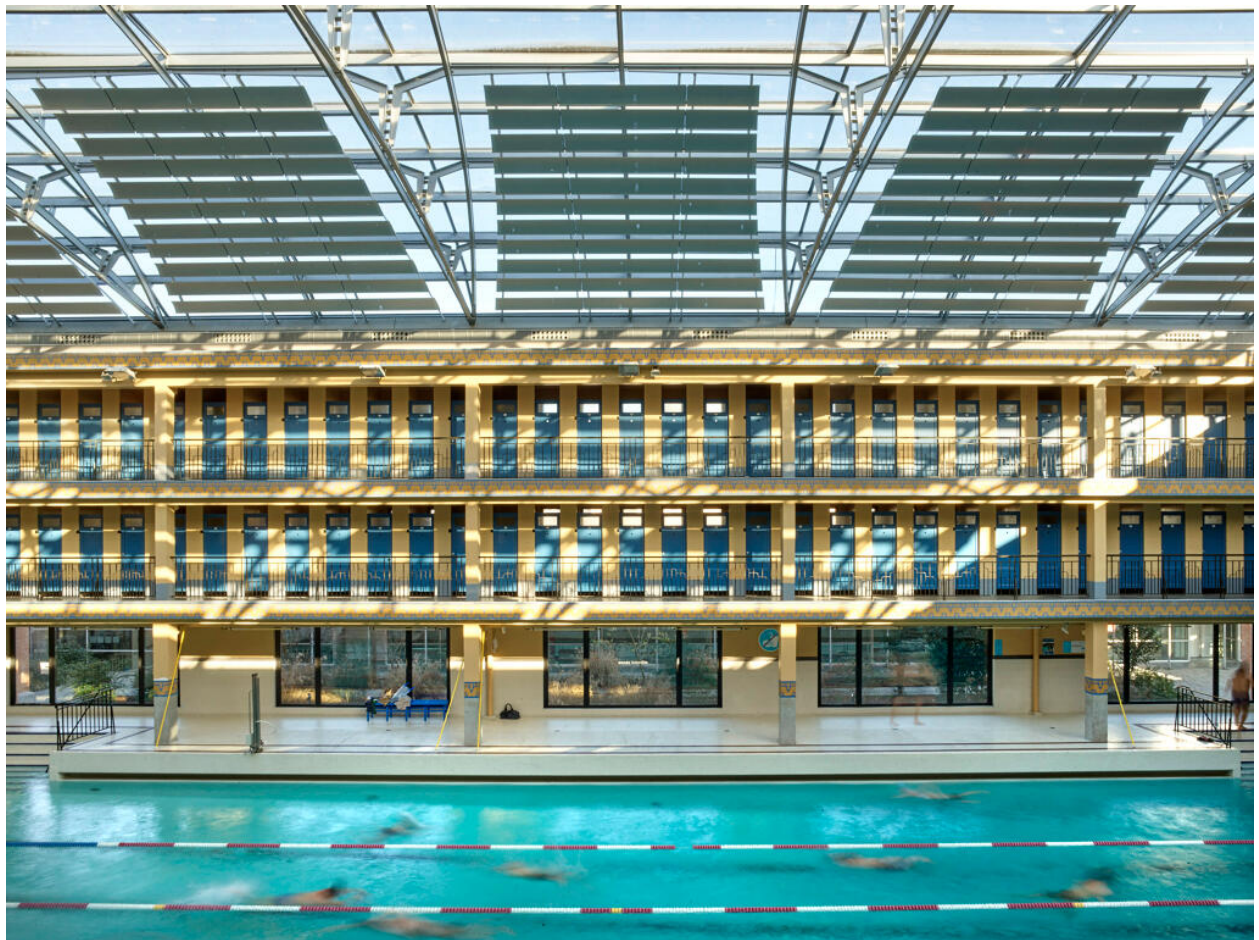
Piscine Pailleron, Vue d'un grand côté des étages de cabines et pare-soleil en couverture.
