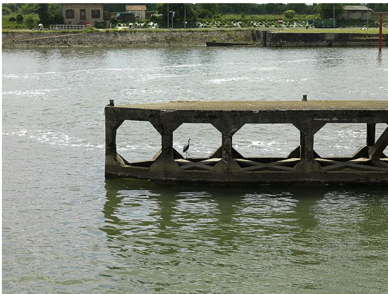
Ablon-sur-Seine, Vigneux. Barrage éclusé. Détail de l'estacade de guidage.
