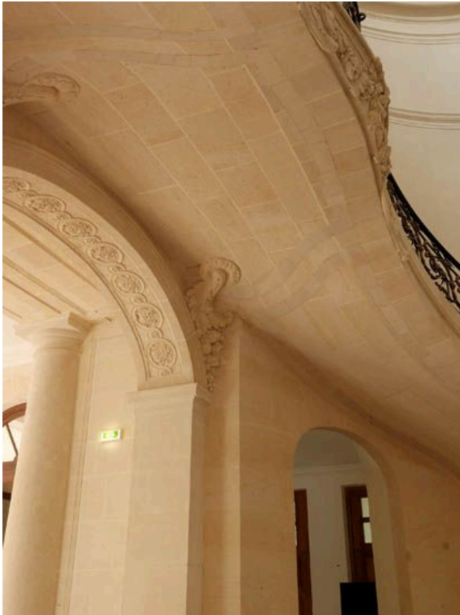
Vue de la stéréotomie de la voûte plate du palier.
