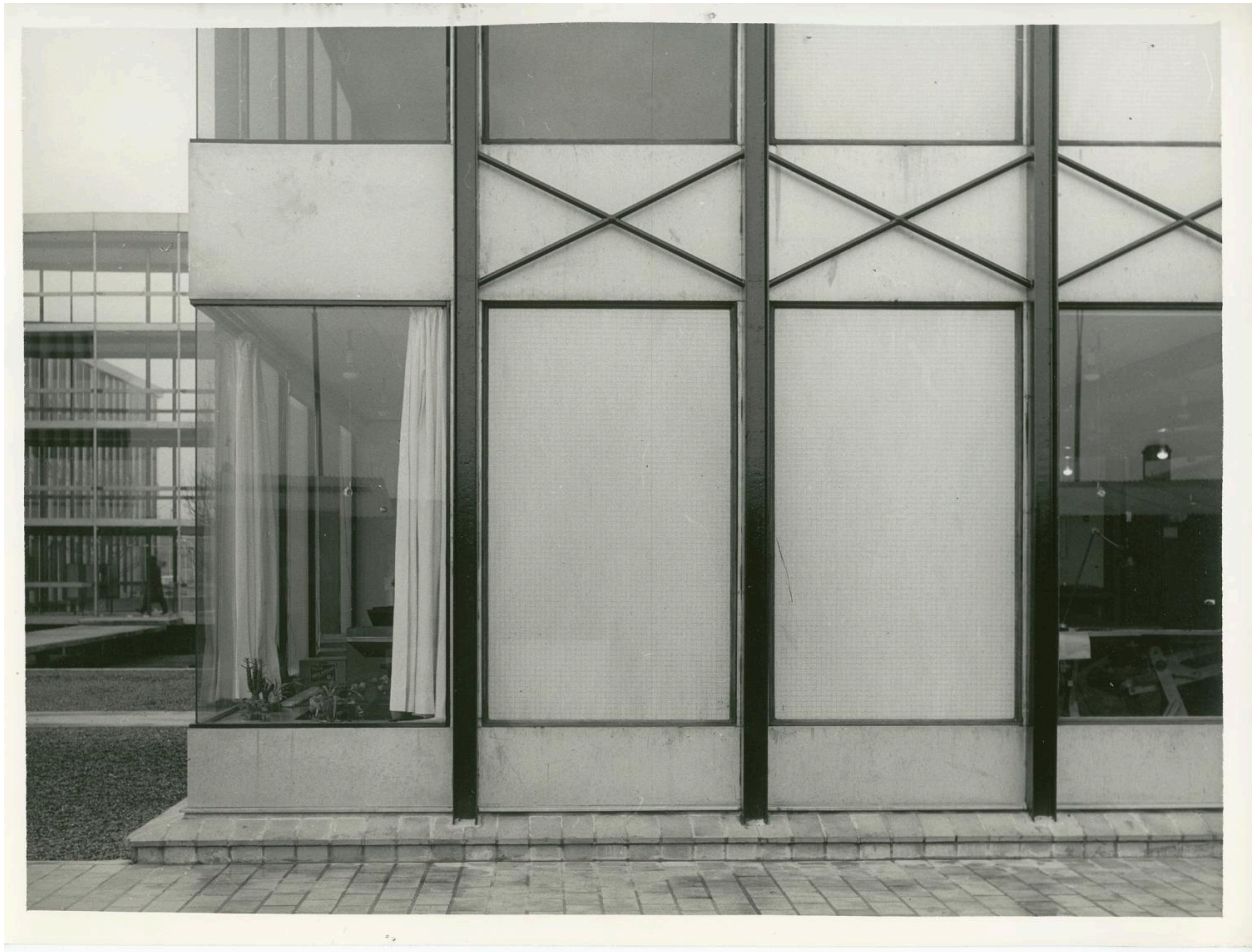
1961, le siège d'Air France ou bâtiment 363
