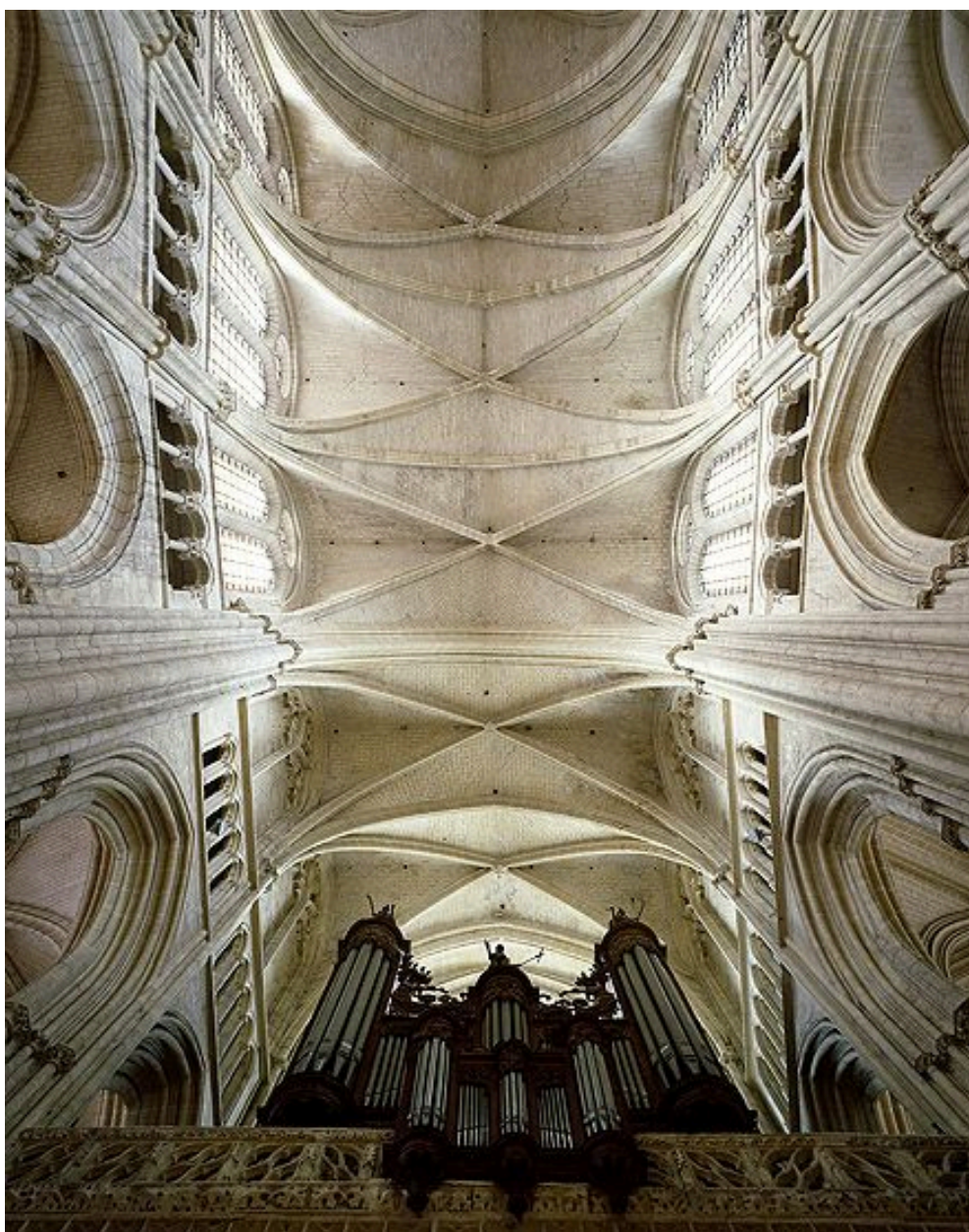
Les voûtes de la nef.
