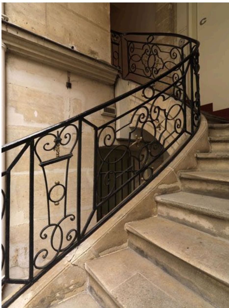
Départ de l'escalier au fond de la deuxième cour.
