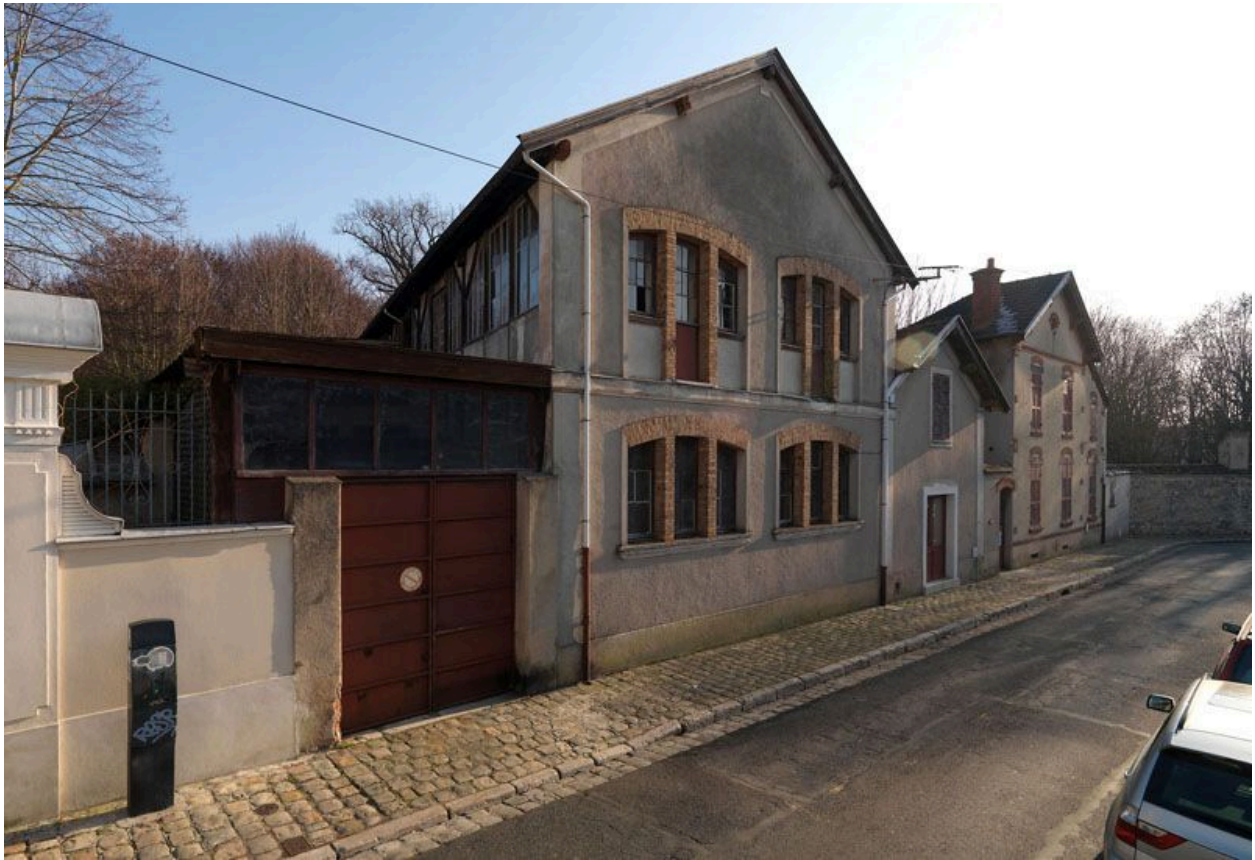
Vue générale de l'usine de menuiserie Parchowski et Chemin.
