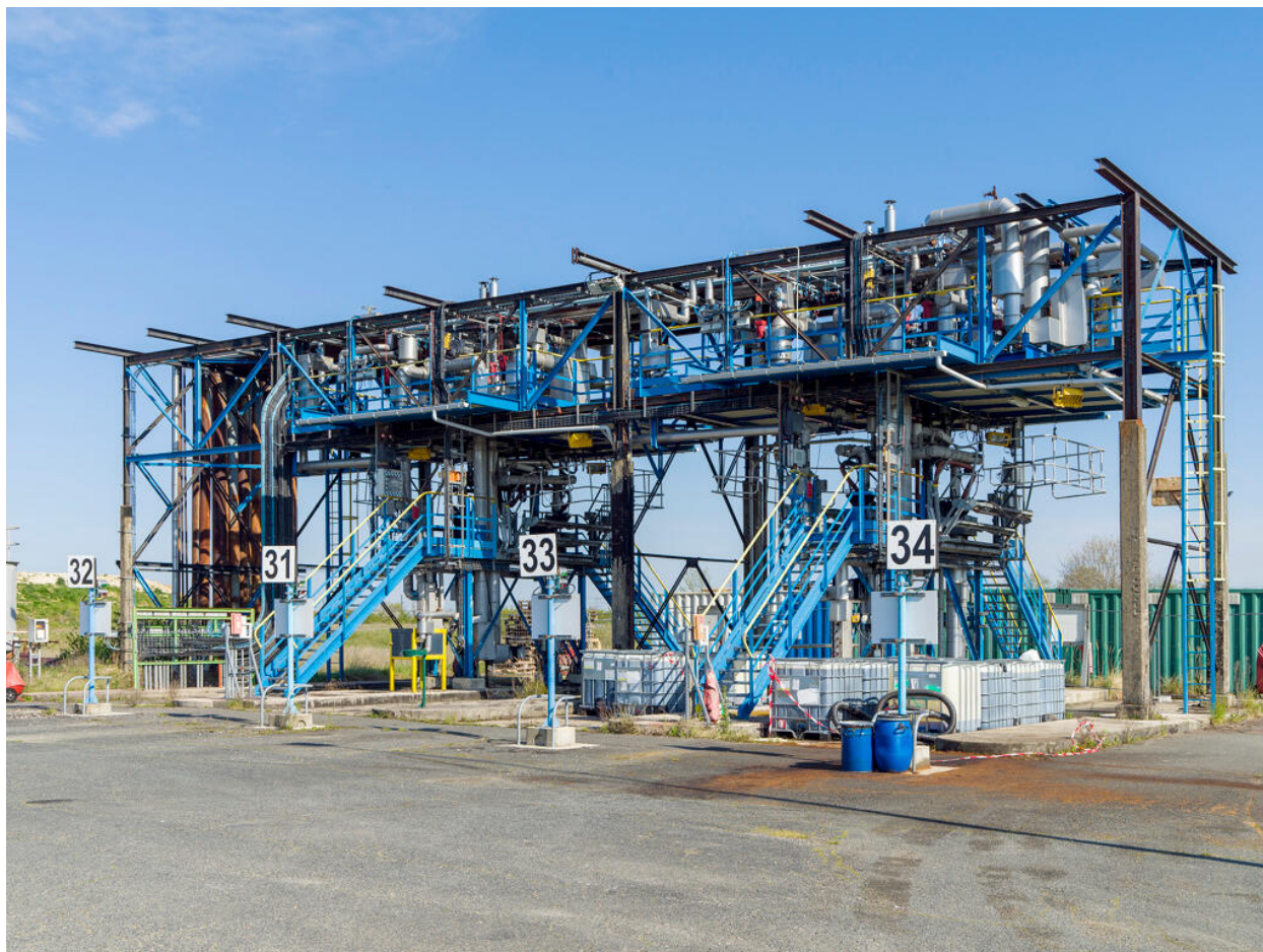
Zone bitume (Unité 570). Quais de chargement bitume.
