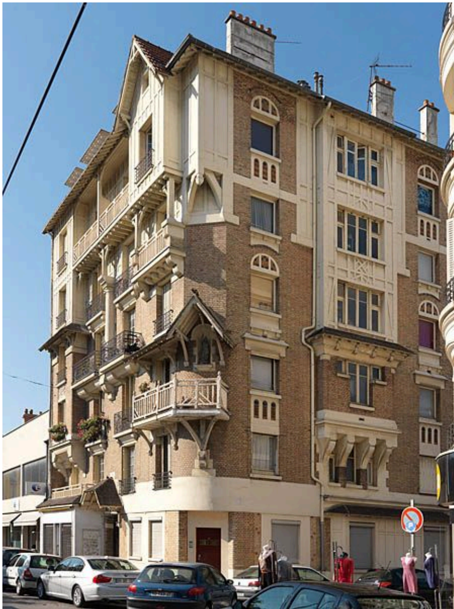
Villeneuve-Saint-Georges, immeuble, 31 rue Henri Janin . Vue d'ensemble.
