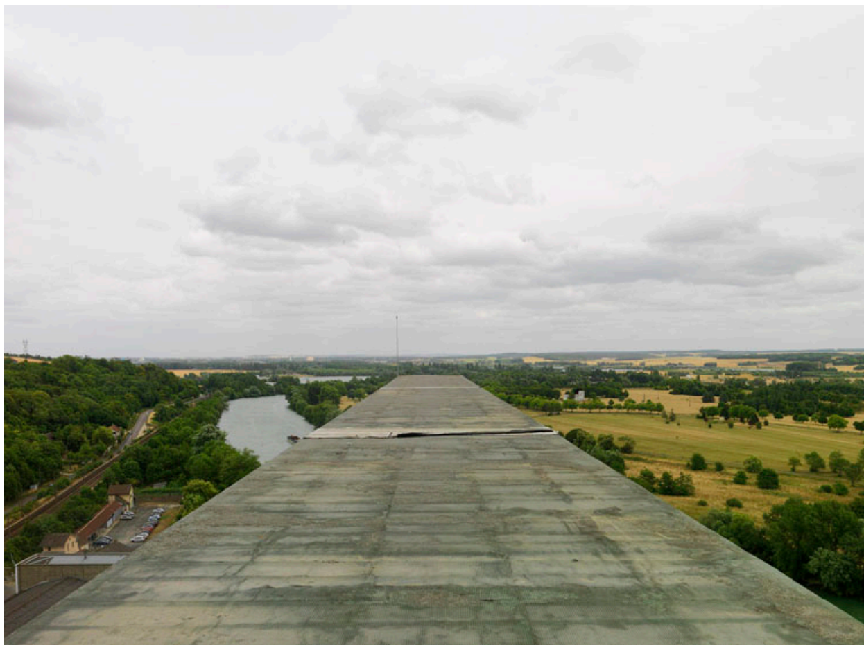
Silos de l'UNCAC de la Grande Paroisse, aujourd'hui Invivo. Vue sur La Seine depuis le sommet du silo 6.
