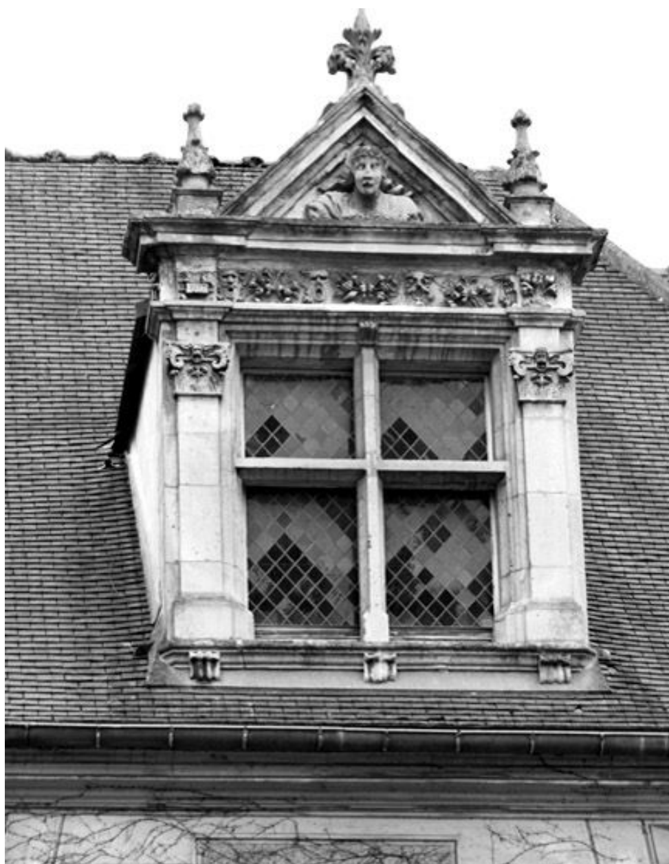
Vue de la lucarne occidentale.
