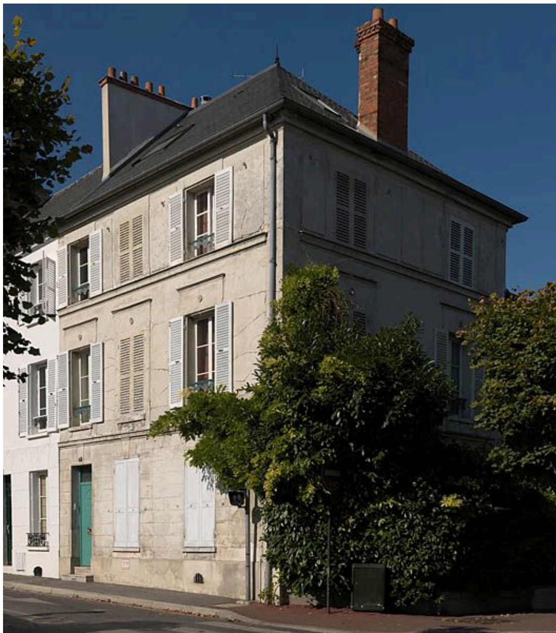
Maison 17, rue du Palais-de-Justice. Maison de faubourg de grand module, avec travée feinte.
