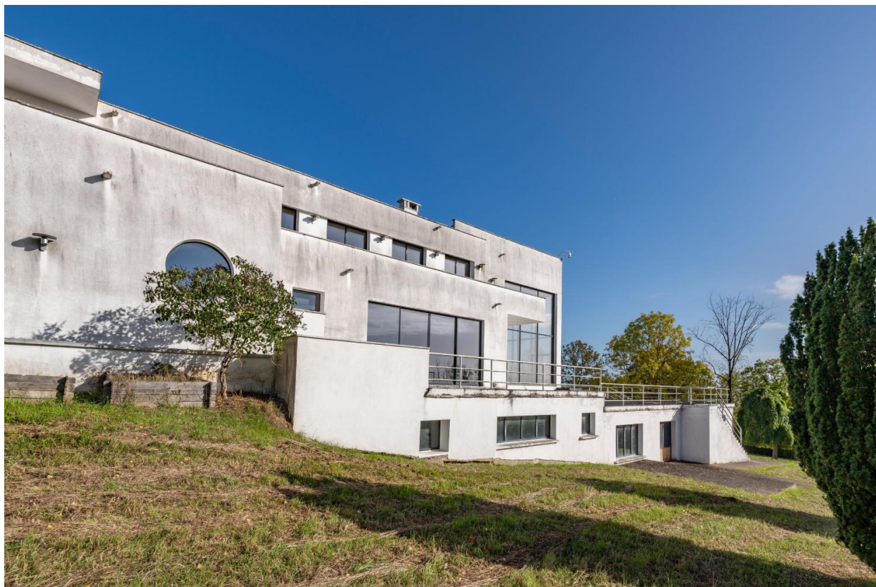
Villa Poiret, façade sud
