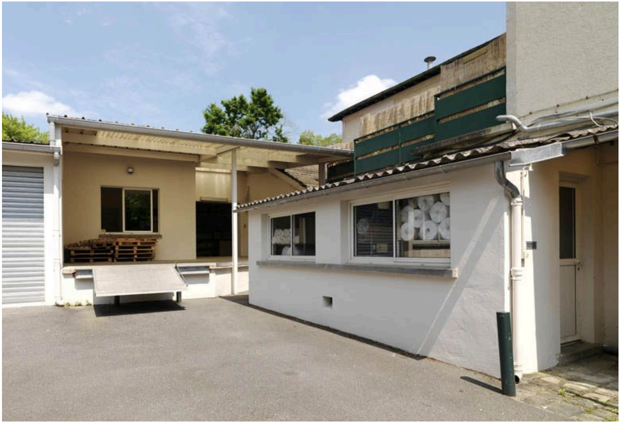
Vue de l'ancien local des lavabos et du quai de chargement.
