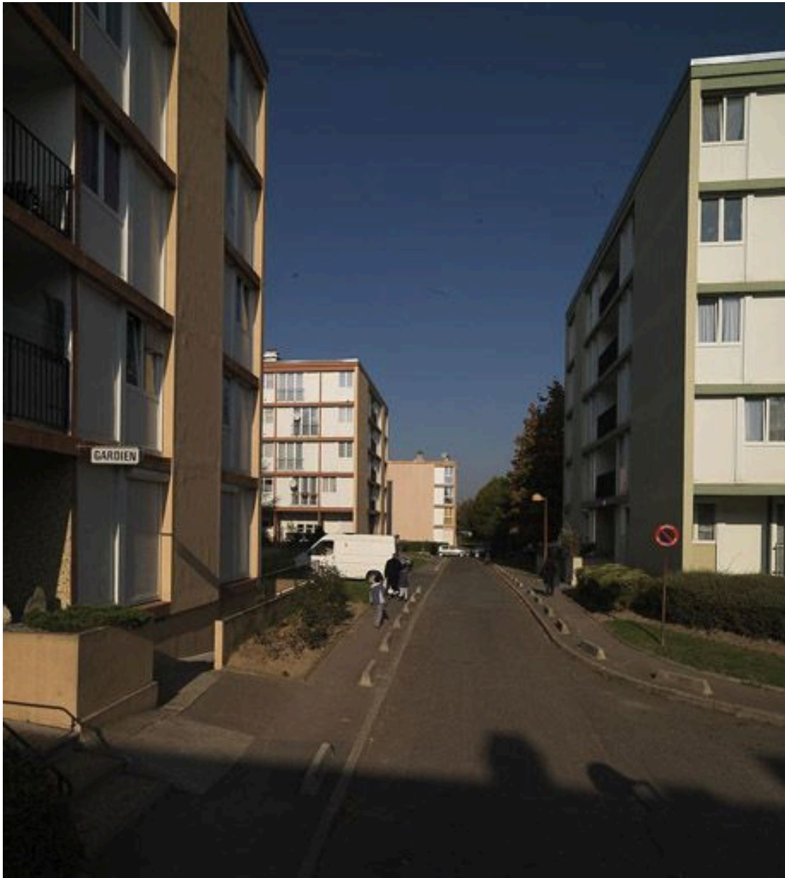
Ensemble de bâtiments ""pavés"" ou plots le long de la rue Paul-Verlaine.
