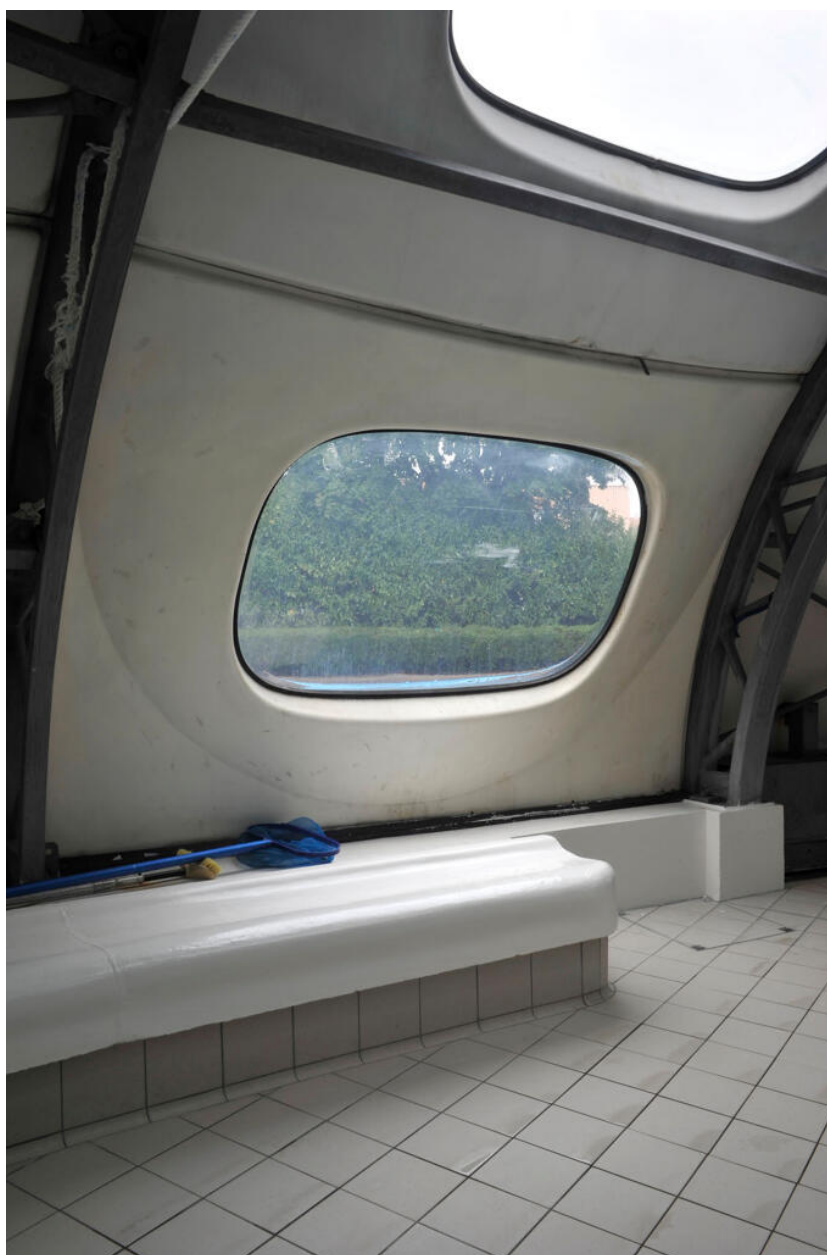
Détail intérieur : hublot et banc. Piscine tournesol de la Cavée
