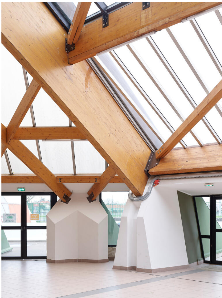
Le palais omnisports de la ville de Thiais. Détail des charpentes.
