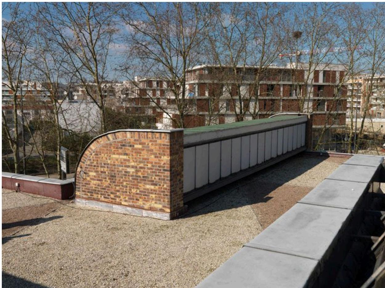
Détail depuis les toit du shed en arc de cercle permettant d'éclairer l'amphithéâtre. Des volets de métal permettent de moduler l'ouverture et la fermeture de cet éclairage.
