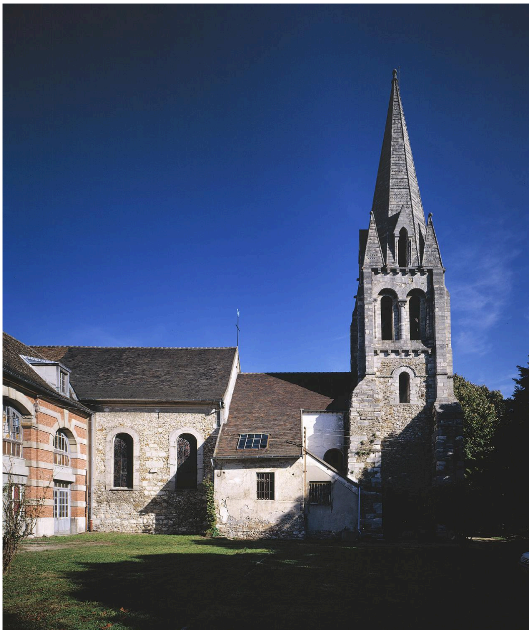
Vue d'ensemble de la façade sud donnant sur le parc du lycée Saint-Charles.
