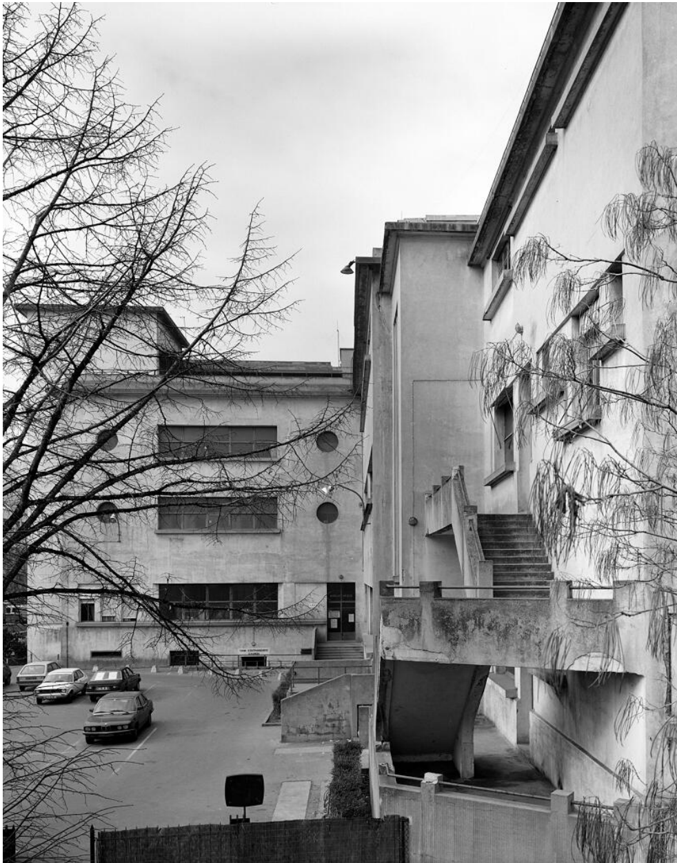
Stade, façade latérale du corps central. Groupe Scolaire, Complexe Sportif dit Ecole Maternelle Aristide Briand et Lycée Professionnel Paul Lapié, dit Stade Municipal
