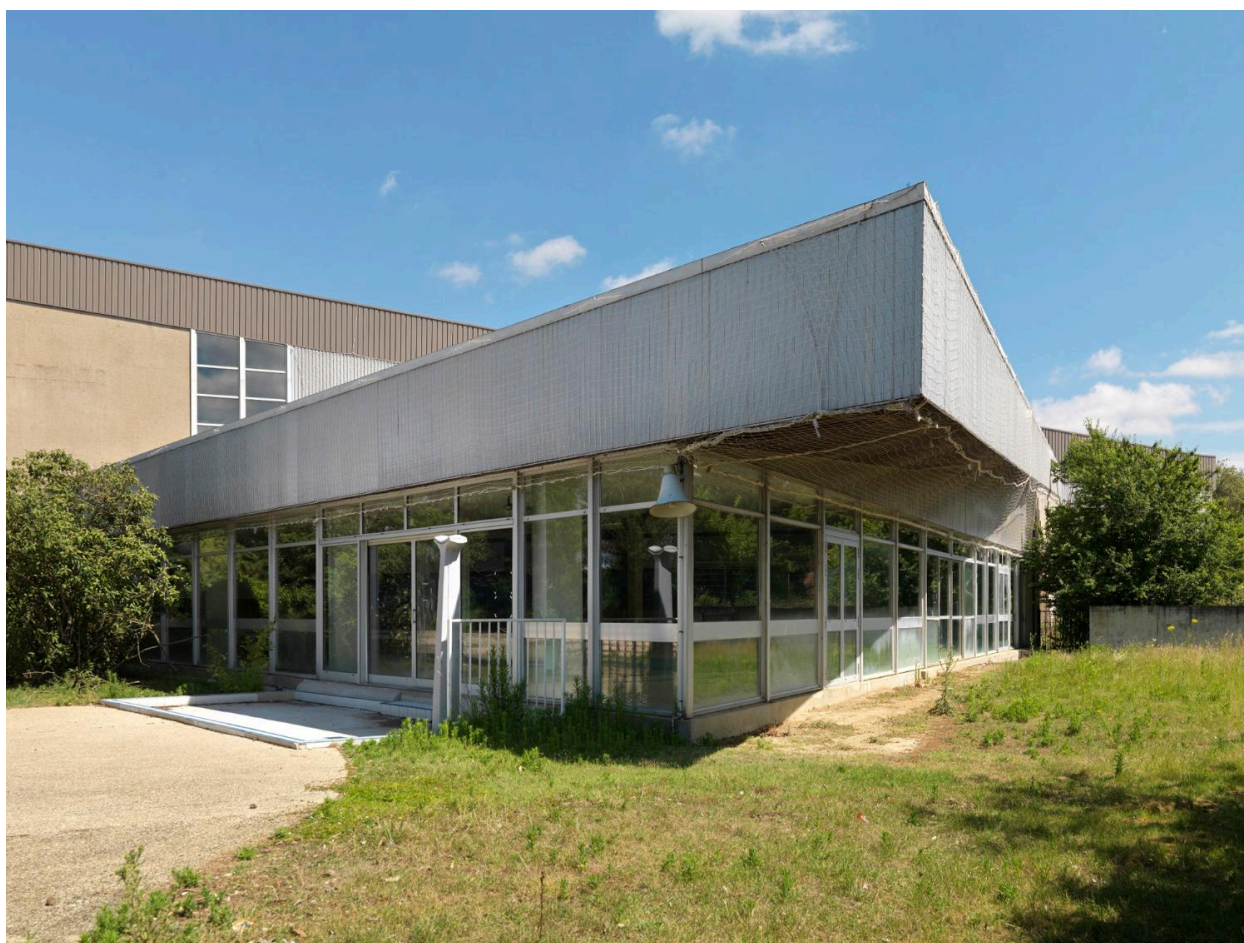
Vue générale de l'entrée de la piscine olympique de Colombes.
