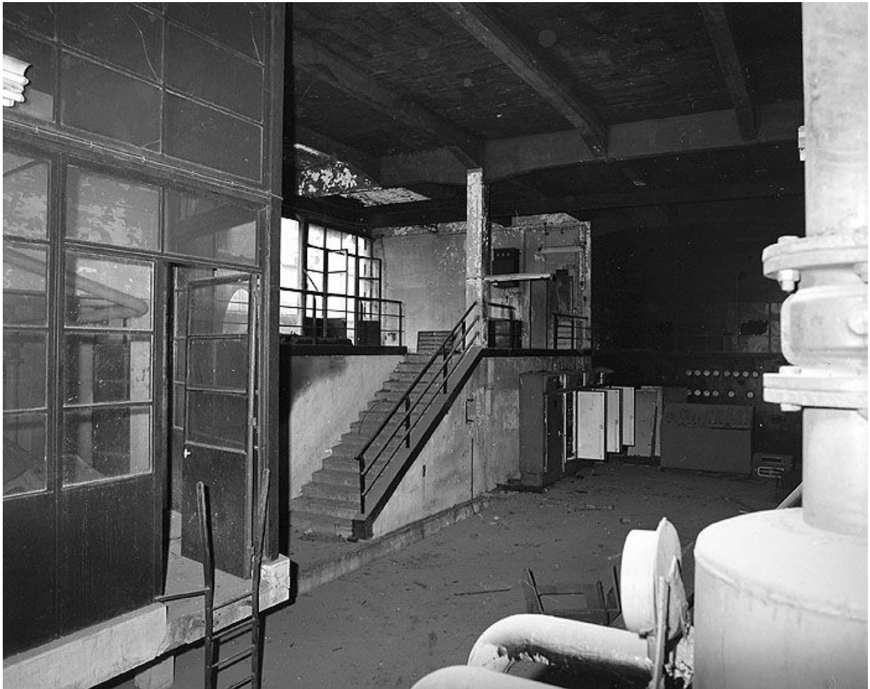
Chaufferie, niveau des cuves. Campagne photographique, lors de la destruction du bâtiment en 1976.
